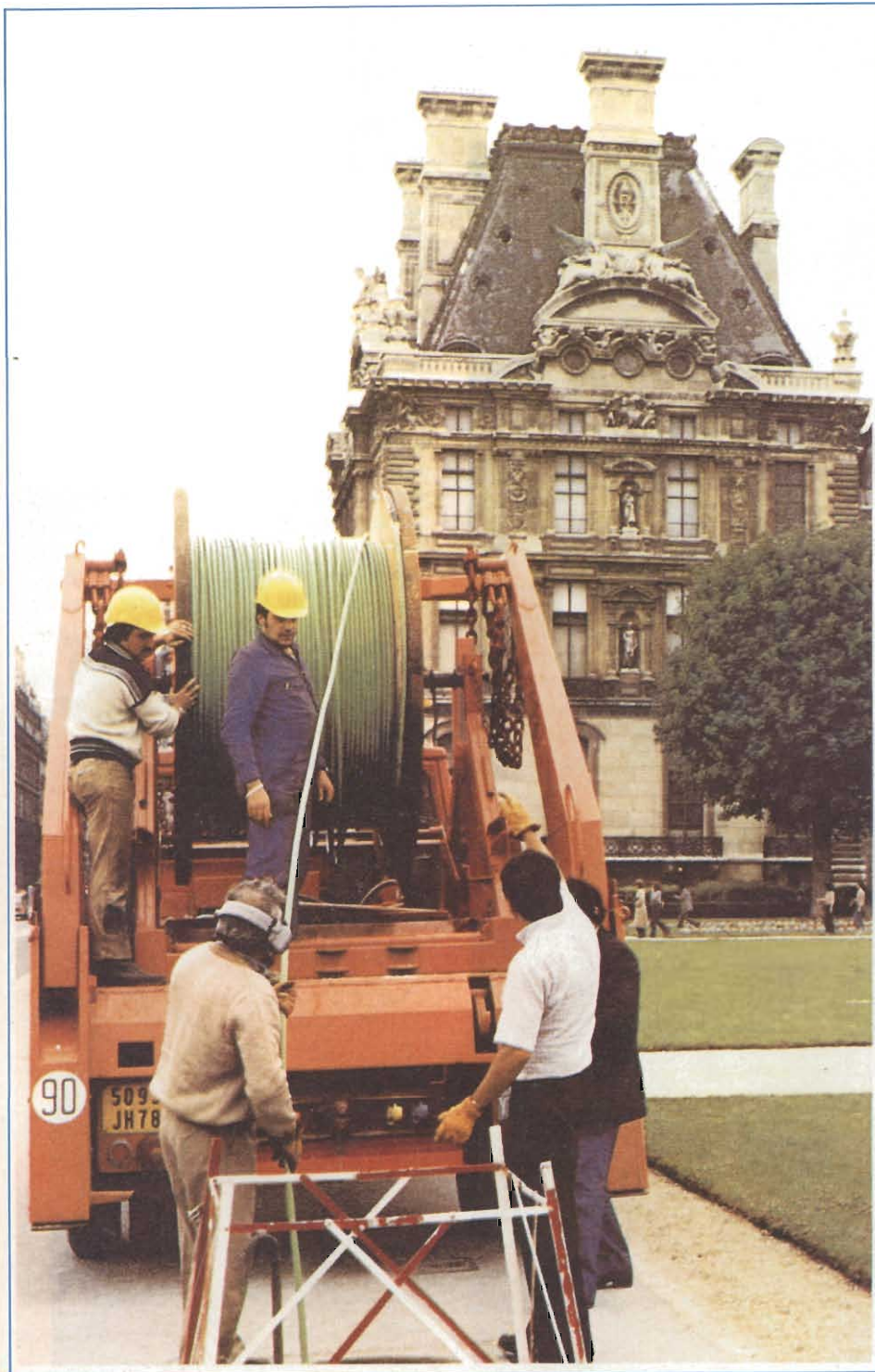
Installazione del primo cavo in fibra ottica destinato al collegamento tra le due centrali telefoniche parigine, Tuileries-Philippe-Auguste.
